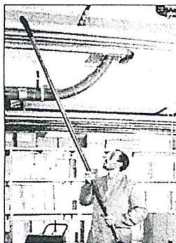
Limpiar los conductos es esencial
